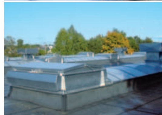
Gewölbte ESSMANN Lichtbänder Typ 940/10 als Träger für die ESSMANN Luftansaugkanäle der unten liegenden Zuluftgeräte und ESSMANN Allwetter-Doppelklappen
